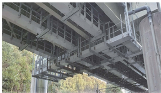
橋梁下に設置される検査路の各部品を締結する
