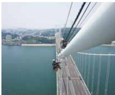
高所作業には危険が伴うため、安全な作業環境の確保と熟練した作業者が不可欠です。労働安全衛生法では、高さ2メートル以上で行う作業を「高所作業」と定義し、規定を満たす強度の命綱や安全帯を着用、足場を組むなどの安全措置を取ることが義務付けられています。当社では、法令の厳守はもとより、さらに高い安全性を確保し、高品質な作業を実現するために作業の標準化とマニュアル化を行いました。更に、独自の特殊高所技術を確立し、作業者がこれを習得できるようにするための体系的な教育・研修システムを構築してきました。
