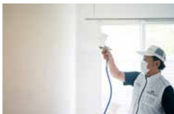
施設・住宅空間にも施工
