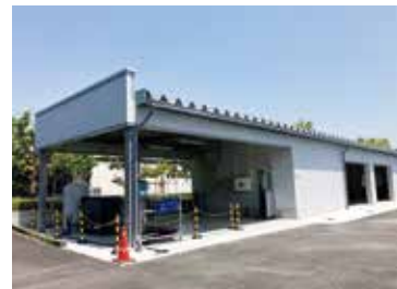
KICKに設置した実証試験施設
