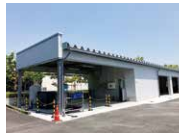
KICKに設置した実証試験施設
