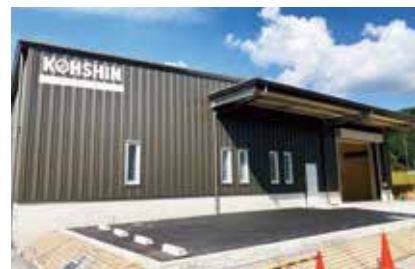
新設した園部工場
