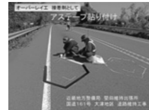
補修面の周囲に「アステープ」を貼り付け、剥離紙を剥がします。マスキングテープは不要です。
