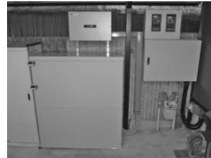
積算電力量計(右上) パワーコンディショナー(右下) 蓄電装置(左下)
