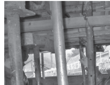
橋桁や張り出し床板など真上にも充填材の注入が可能
