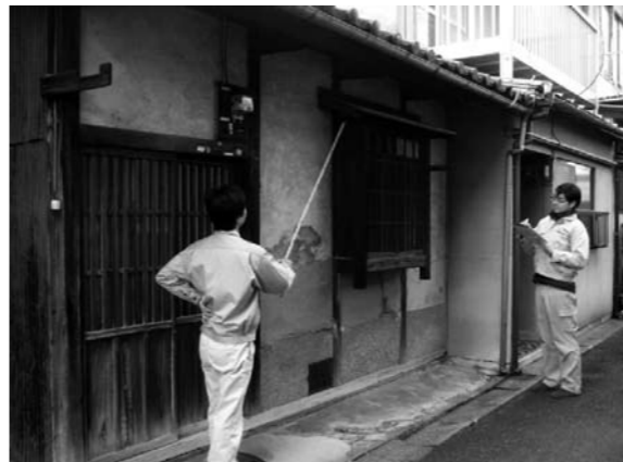
「空き家見守り隊」町家見回り中（建物外部からのチェック）
