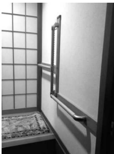
介護保険を活用した住宅改修の事例（手すりの取付け）
