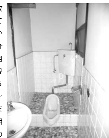
介護保険を活用した住宅改修の事例（上…利用しにくい和式便器、下…洋式便器、手すりも設置）
