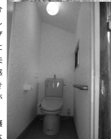
介護保険を活用した住宅改修の事例（上…利用しにくい和式便器、下…洋式便器、手すりも設置）
