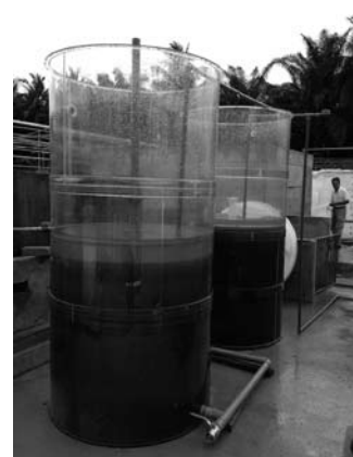
MIYABIシステムタンク設備工事の様子
