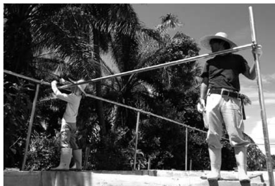
マレーシアペナン州における養豚場建設工事の様子
