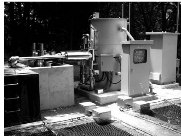
自動逆洗付細砂ろ過システム導入事例
