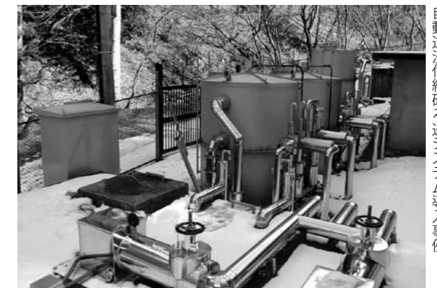
自動逆洗付細砂ろ過システム導入事例
