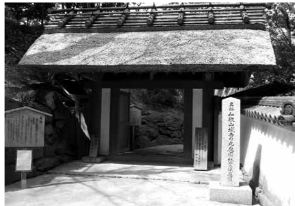
伝統工法の施工例「和歌山城紅葉深庭園門」
