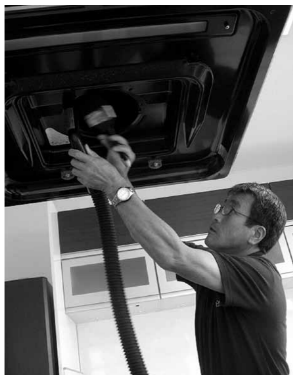
『ホームメンテ』作業の様子
