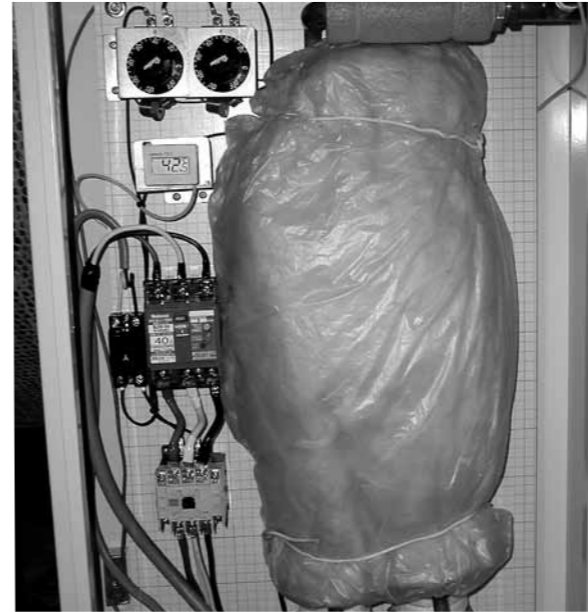
パイプを通るお湯を加熱する昇温器
