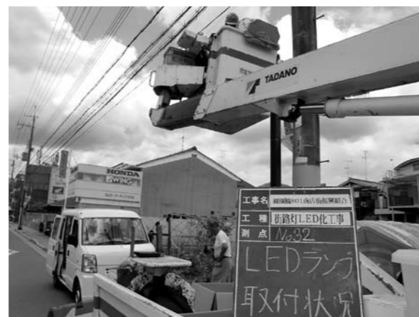
LED取付け工事中
