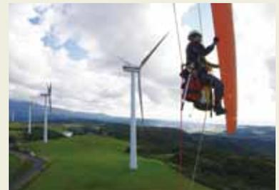
風力発電設備での点検の様子
