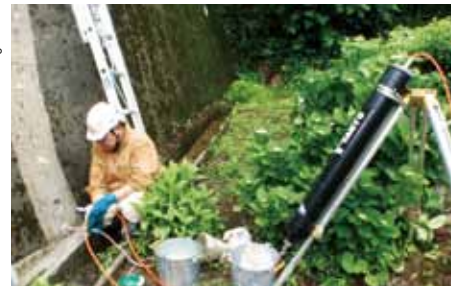
「GARYA-A」工法での修復作業
