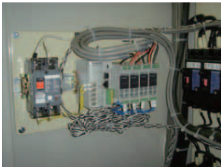
図1 計測器の外観・設置状況
