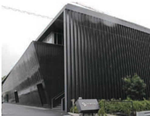
▲2007年に完成した本社工屋
