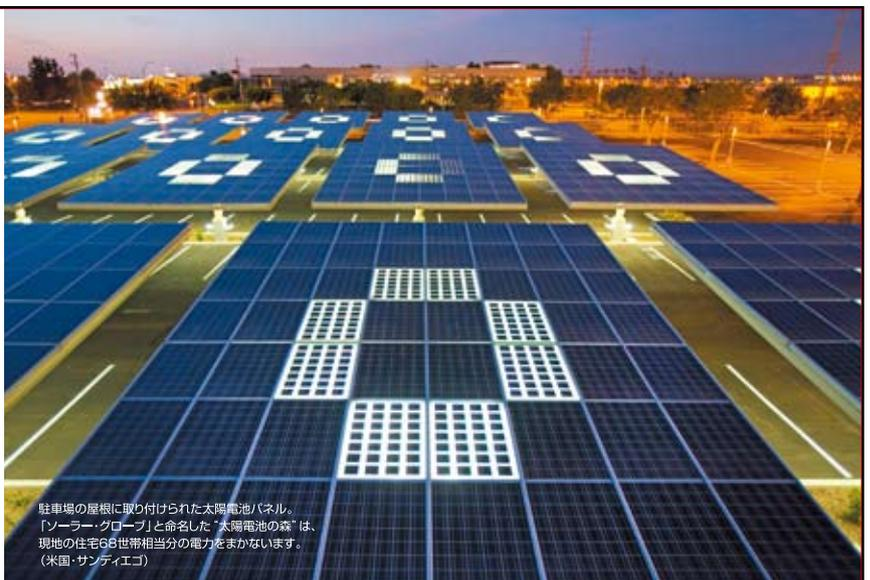
駐車場の屋根に取り付けられた太陽電池パネル。「ソーラー・グローブ」と命名した「太陽電池の森」は、現地の住宅6世帯相当分の電力をまかさないです。(米国・サンディエゴ)
