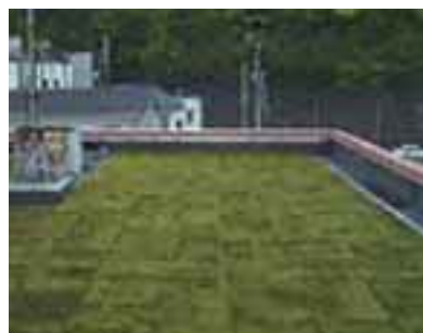
コケを用いた屋上緑化の様子
